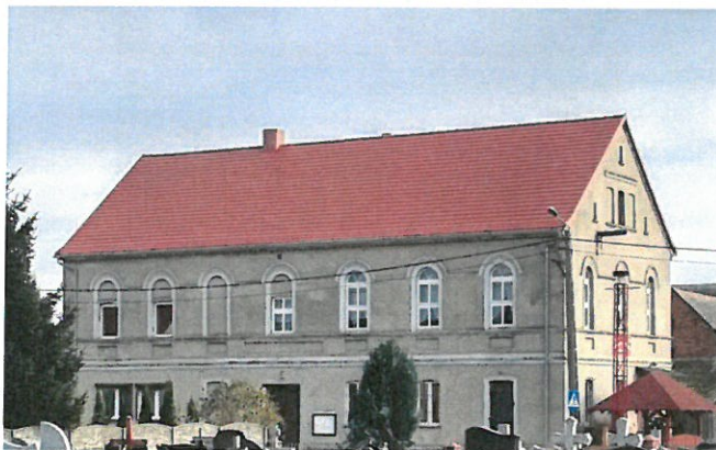
Dach na budynku wiejskim w Miechowie
