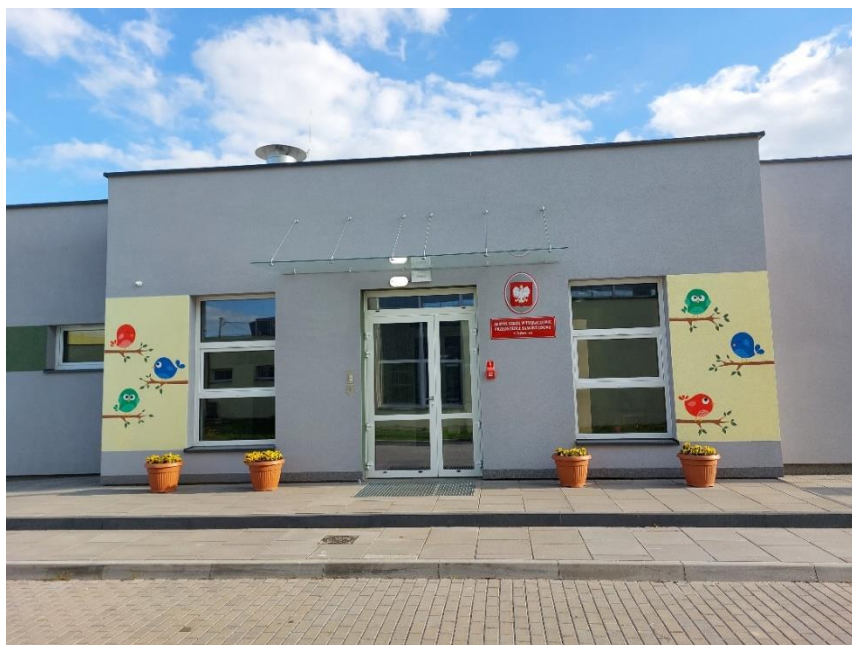
Budynek Przedszkola w Trębaczowie
