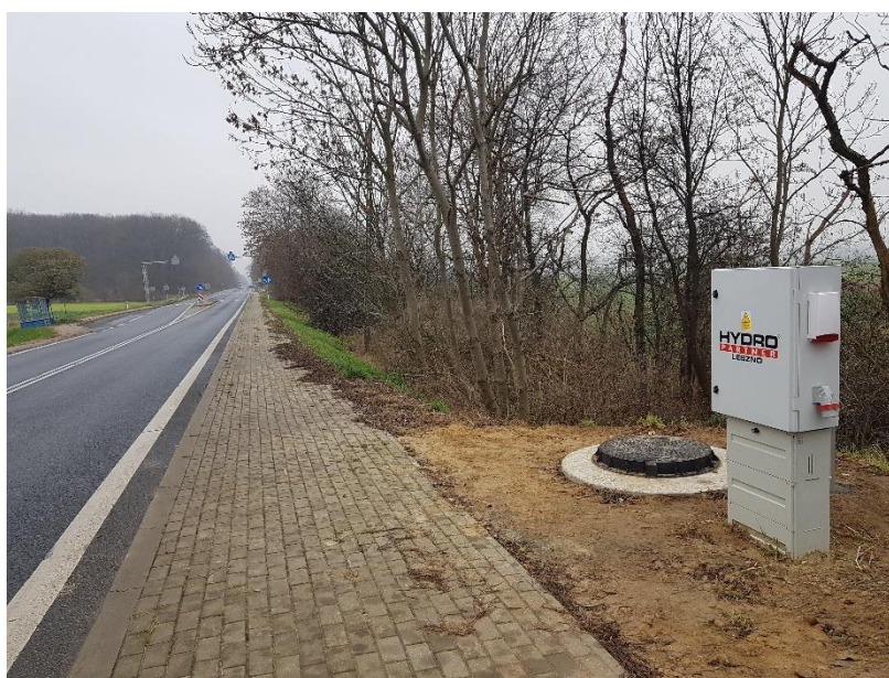
Kanalizacja w Słupi pod Bralinem
