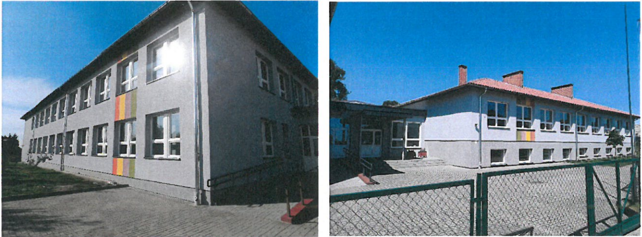
Budynek ZS w Perzowie po termomodernizacji
