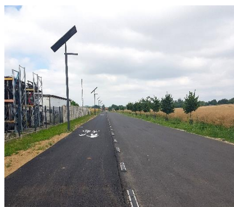
Nowa droga w Słupia pod Bralinem
