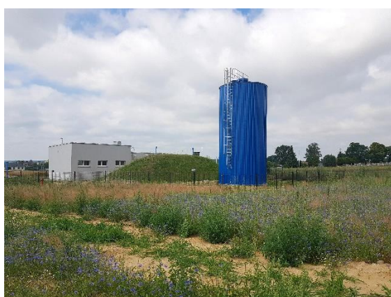
Nowy zbiornik wody w Słupia pod Bralinem
