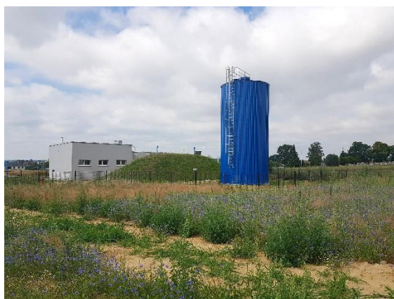
Nowy zbiornik wody w Słupia pod Bralinem
