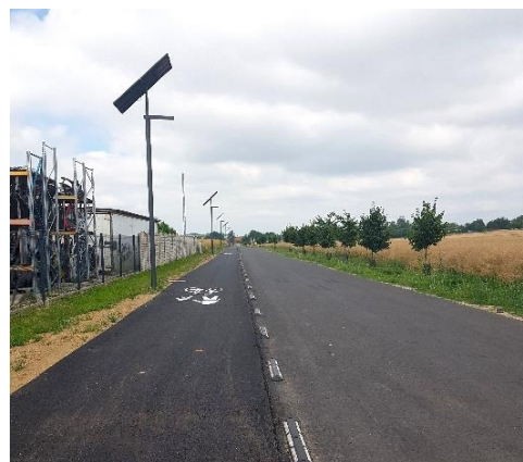
Nowa droga w Słupia pod Bralinem
