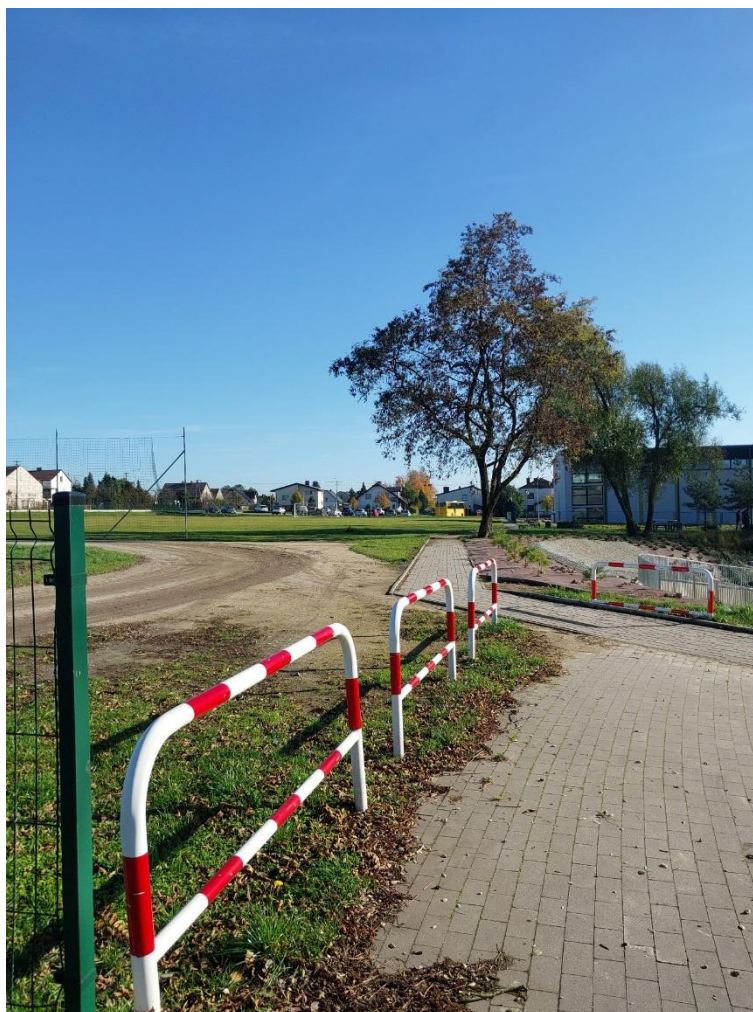
Ryc. 13 Obszar przy terenie rekreacyjnym i boisku sportowym w Perzowie Źródło: dokumentacja fotograficzna wykonana podczas wizji lokalnej w dniu 4.11.2025 r.
