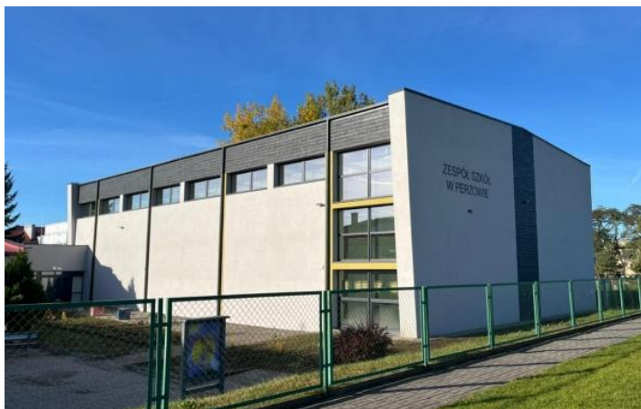
Budynek sali gimnastycznej
