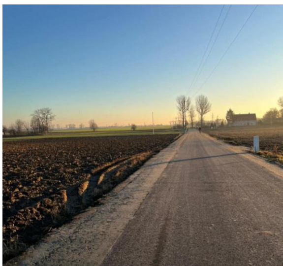
Droga gminna w Perzowie (za remizą)
